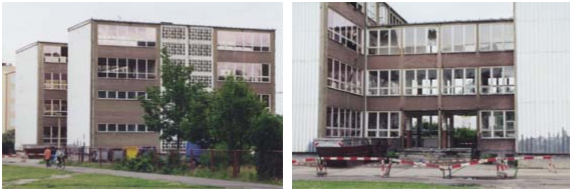
Bild 21 u. 22. Das Schulgebäude wird "entkernt".
