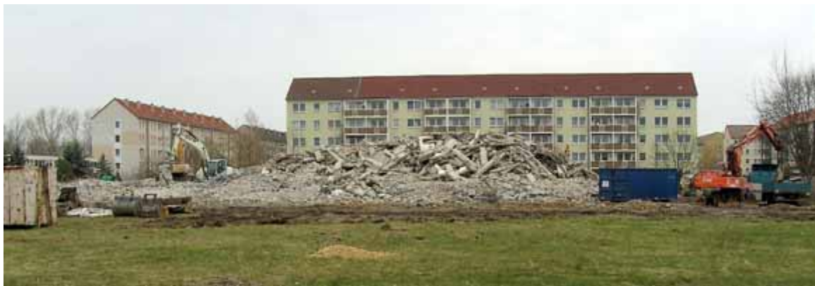
Bild 19. Nach dem Abriss im April 2008
