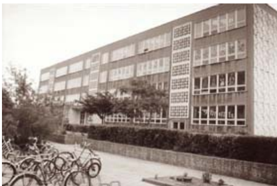
Bild 15. Polytechnische Oberschule "Arthur Becker" eröffnet im März 1971 — Bau- und Ausstattungszeit von 1968 bis 1971
