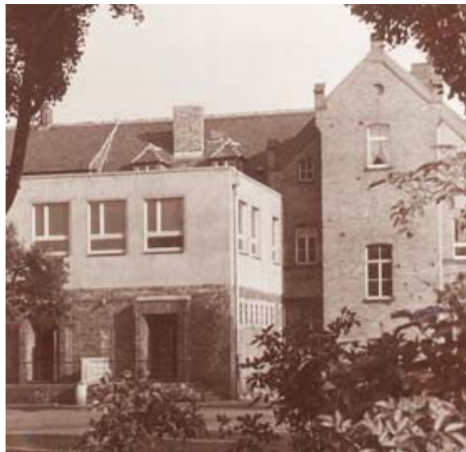
Bild 11. Der Anbau eines Klassenraumes im Jahr 1967 erfolgt durch die Mitarbeit der Schüler der Klasse 10b in der Grundausbildung Bauwesen.
