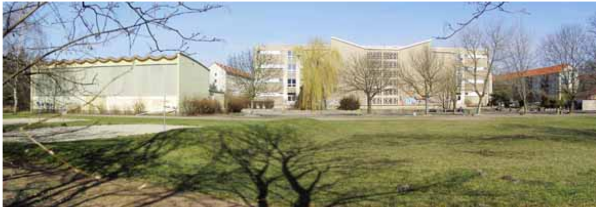
Bild 18. Turnhalle und Schulgebäude des Gymnasiums im März 2007
