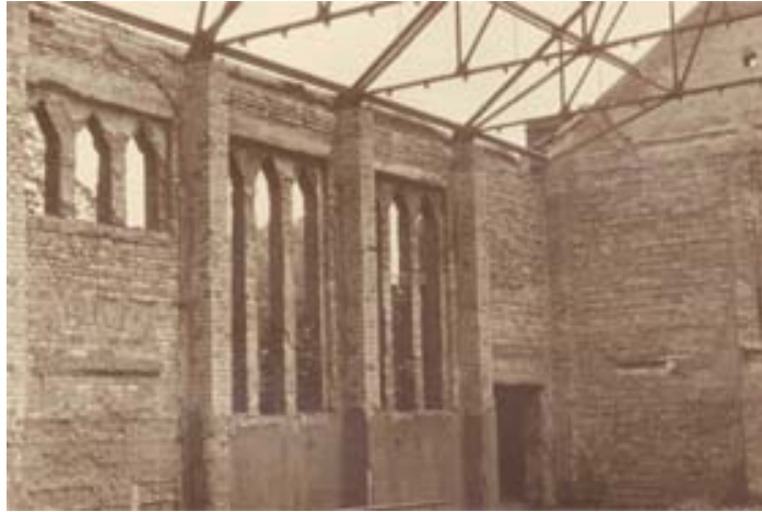
Bild 9. Die ausgebrannte Turnhalle
