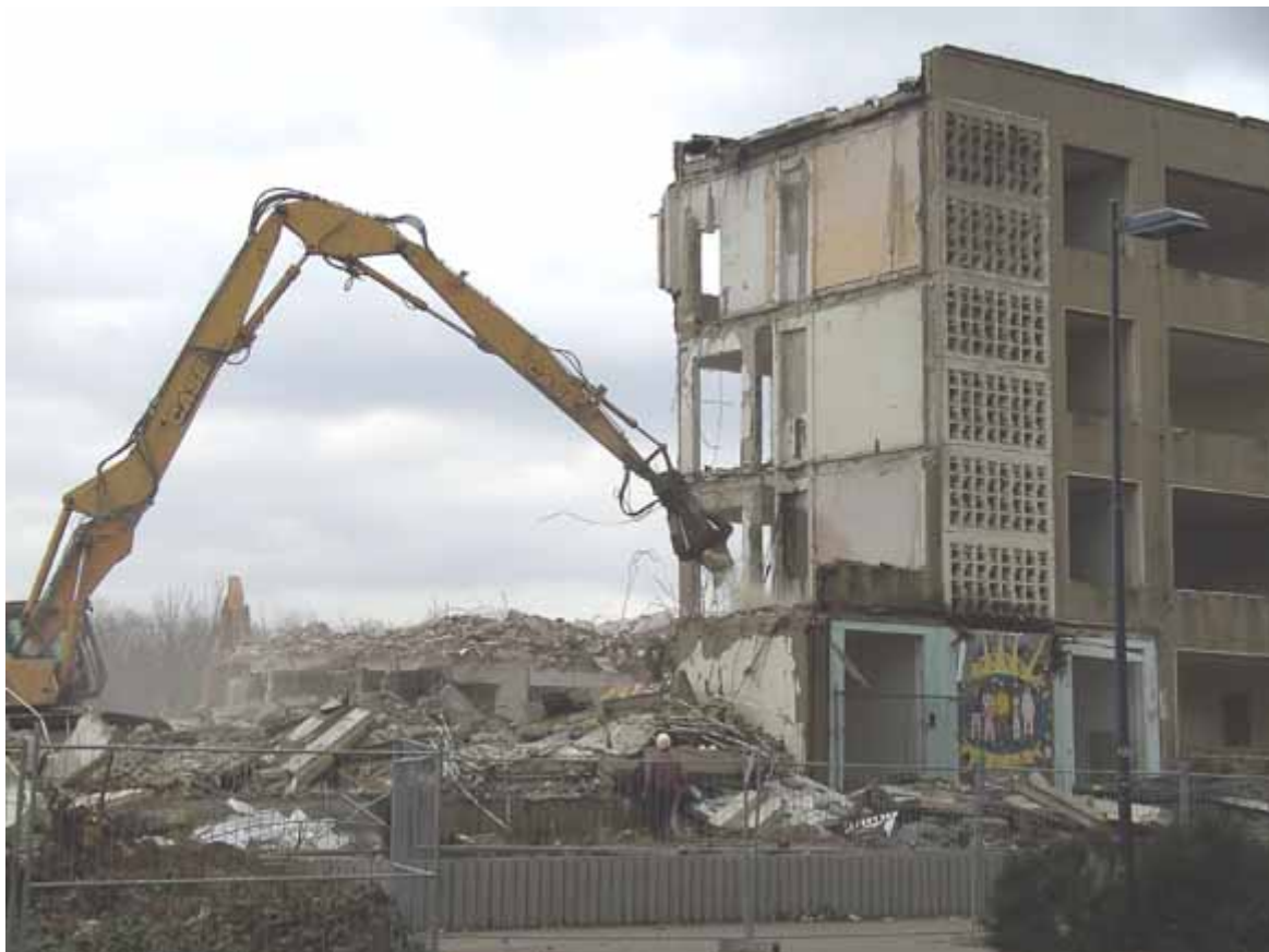
Bild 17. Das Gebäude des Gymnasiums am "Ring der Chemiewerker 66" wird im März 2008 abgerissen.
