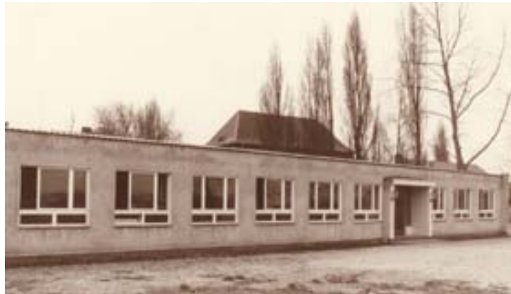
Bild 12. Auf dem Gelände der "August-Bebel-Schule" wird im Jahr 1969 der "Schulpavillon" fertiggestellt. In diesem Gebäude werden Fachkabinette für Biologie und Chemie und die dazugehörigen Vorbereitungsräume mit Lehrmitteln eingerichtet.
