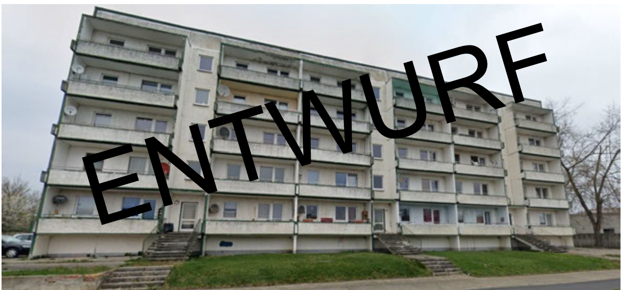
Abbildung 33: freistehendes Mehrfamilienhaus (Baujahr ca. 1970) in Plattenbauweise
