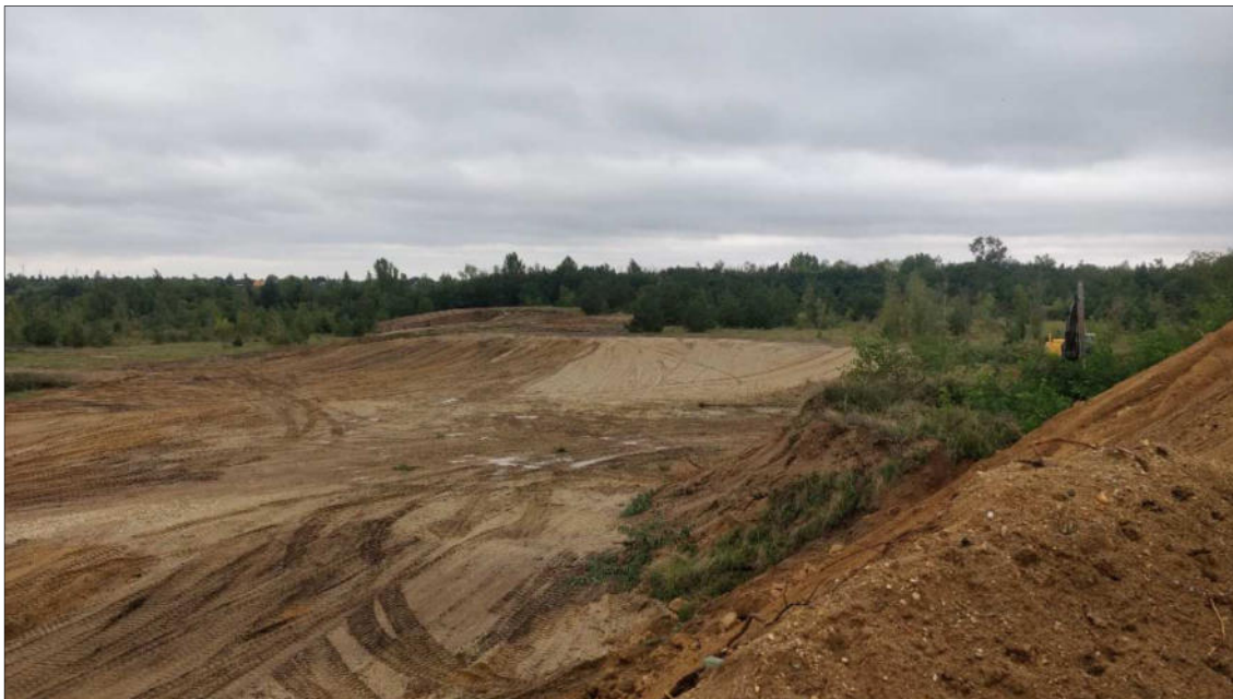
Abbildung 4: Herstellung der geforderten Böschungen (19.09.2022)
