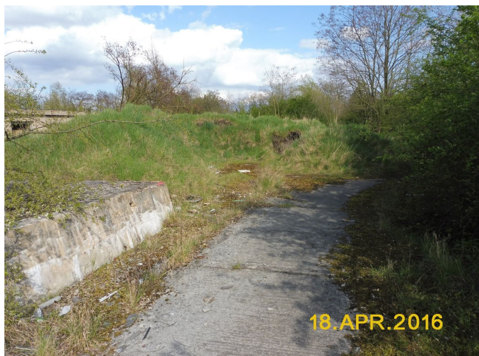
Bild 8: Auch diese Erdaufschüttung liegt auf einer geschlossenen Betondecke
