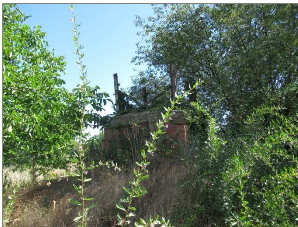
Abbildung 18: Altes Pfeilerfundament mit Sukzessionsgebüsch aus Bocksdorn, Felsen-Kirsche und Walnuss
