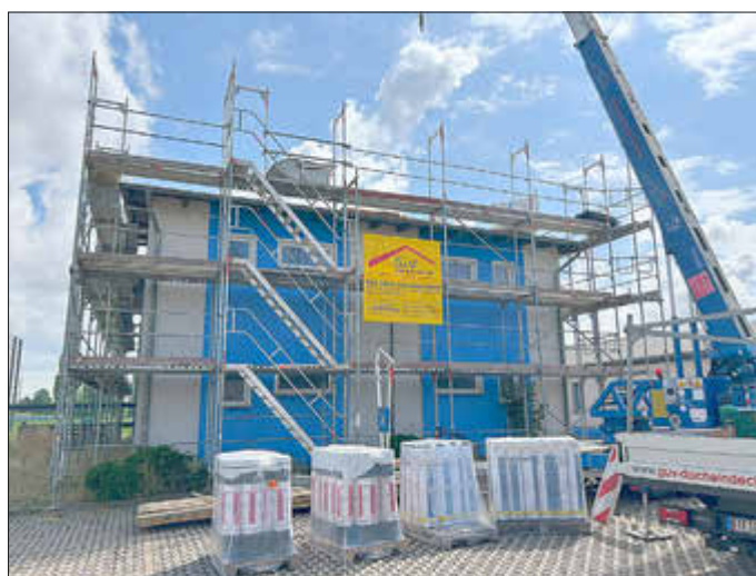
Das Dach des Sportlerheims in Brehna wird saniert.
