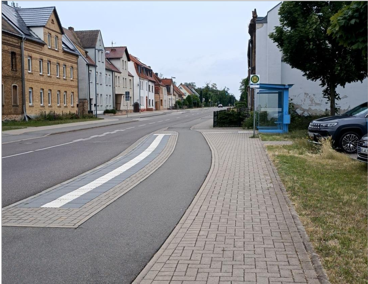
Abb. 46: Sanierter Gehweg Hauptstraße
