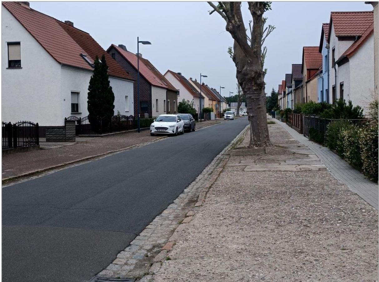
Abb. 45: Unsanierter Gehweg in der Ernst-Borsbach-Straße
