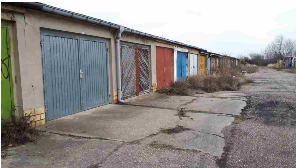
Abbildung 19: Entsiegelung Garagenkomplex (3 Fotos Ist-Zustand)
