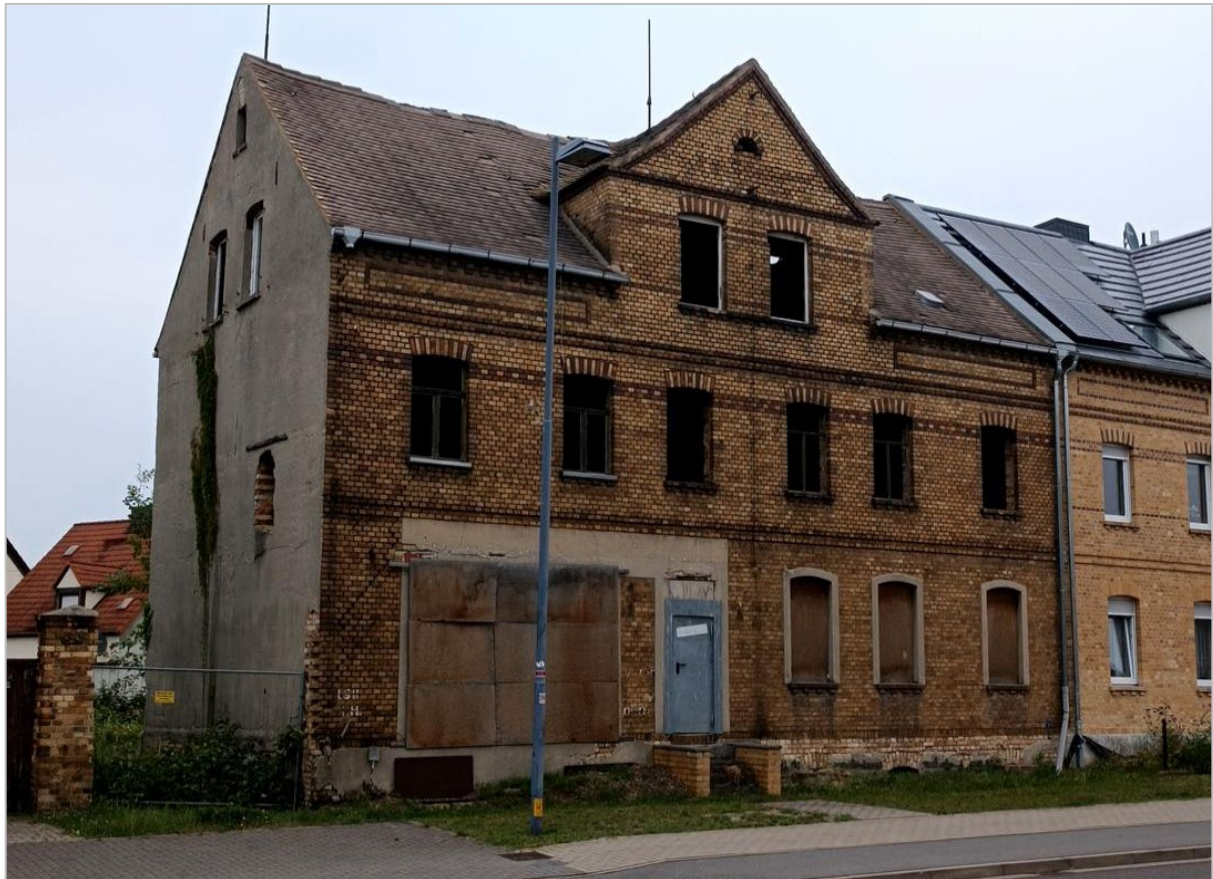
Abb. 18: Backsteingebäude von Verfall bedroht. Gegenüber Bitterfelder Straße 4
