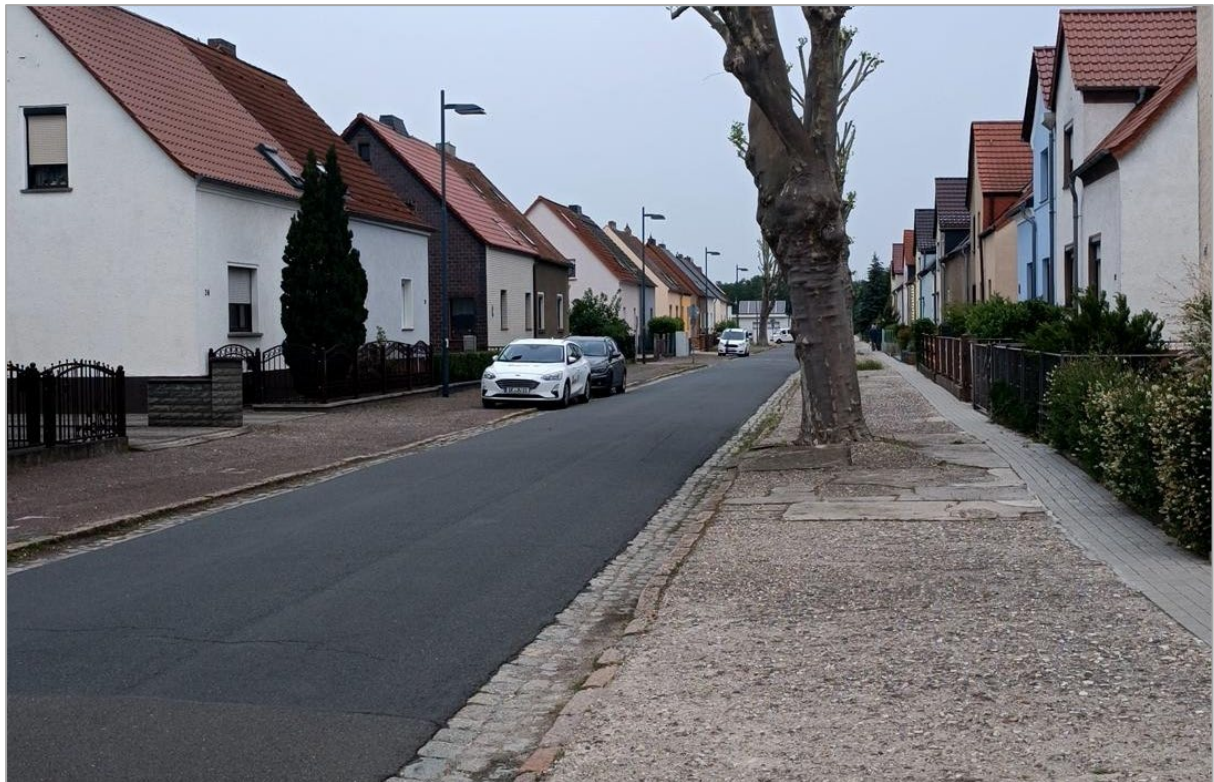
Abb. 46: Unsanierter Gehweg in der Ernst-Borsbach-Straße
